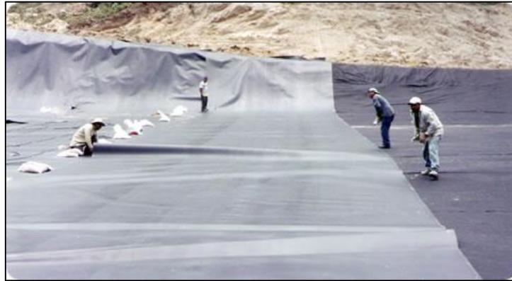
**Figura 2.2.6 Colocación de geomembrana.**
