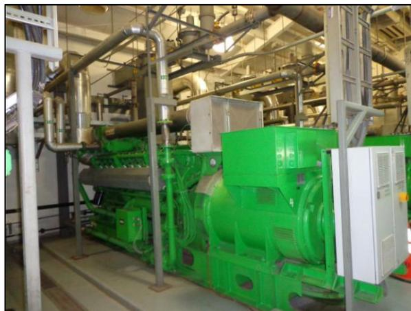
Figura 5.2.4 Motor de combustión que lleva a cabo el proceso de generación.
