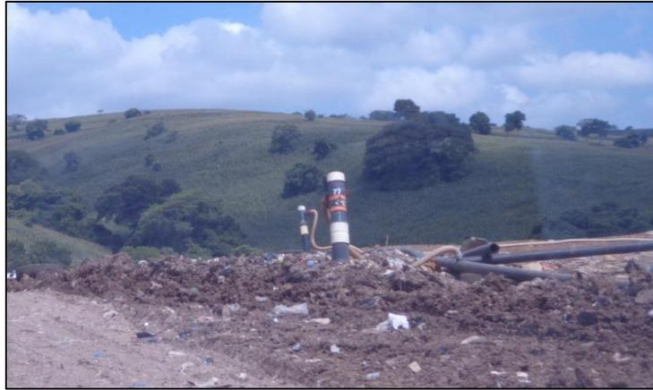
Figura 2.2.8 Pozos verticales activos para la extracción de lixiviados y biogás.
