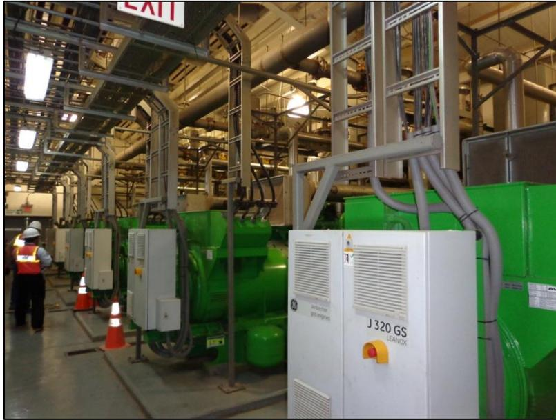
Figura 2.2.14 Motores de combustión utilizados en el proceso de generación.
