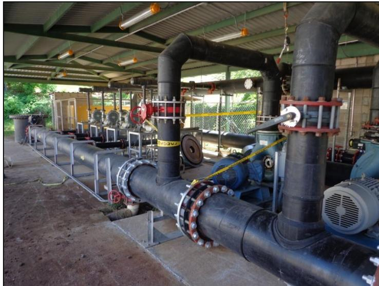
**Figura 2.2.11** Sistema de filtrado por enfriamiento y monitoreo para el biogás.
