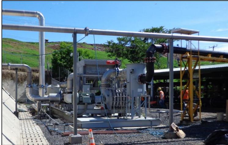
**Figura 2.2.12 Quemador de excedentes de biogás.**
