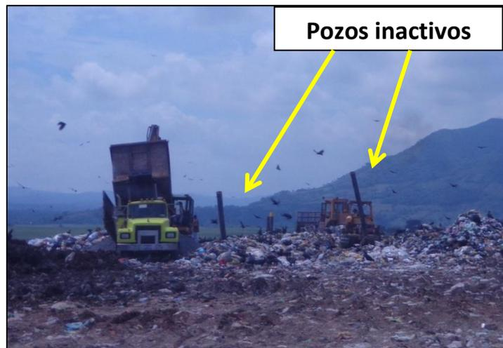
Figura 2.2.9 Pozos verticales inactivos para utilizarse posteriormente.
