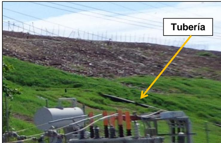
Figura 5.2.1 Tubería de PVC que transporta el biogás del relleno sanitario a la planta.
