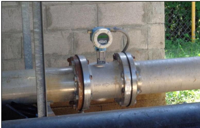
Figura 5.2.2 Medidores de flujo de biogás conectado a la tubería de transporte.
