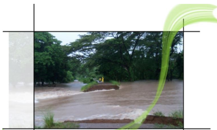
Figura 3. El Bajo Lempa, colapso de la borda aledaña al río Lempa, durante la depresión 12E, a la altura de la comunidad Los Lotes y la Babilonia (Alto Riesgo a inundaciones).
